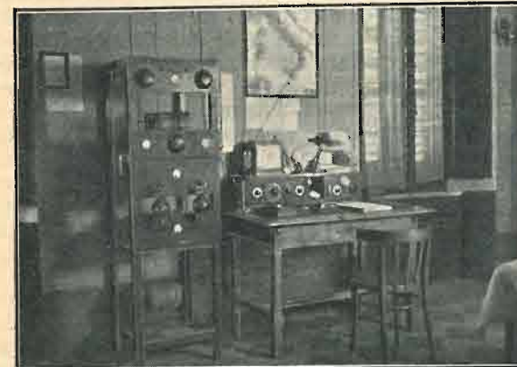
Fig. 6. — Stazione sperimentale italiana (r. EH); a destra il tavolo di ricezione con l'apparecchio « Hart ».
